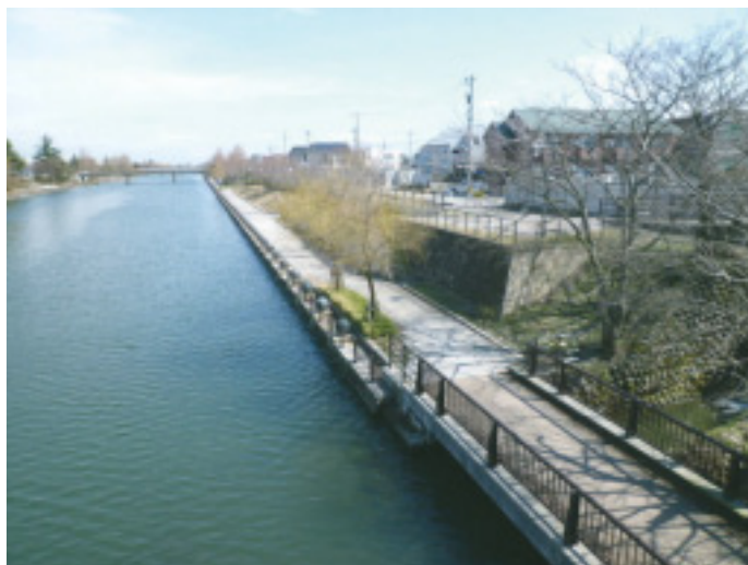
富岩運河（遊歩道の整備）
