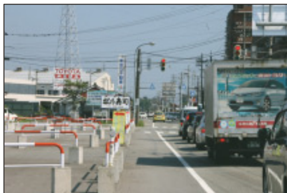
〔東岩瀬線〕 城川原地内
