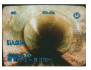
調査の結果、改築の必要ない下水道管
