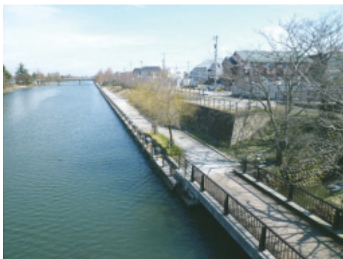
富岩運河（遊歩道の整備）
