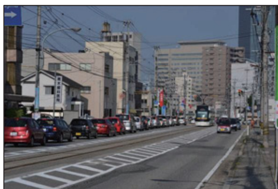
〔綾田北代線〕 永楽町地内
