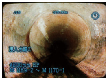
調査の結果、改築の必要ない下水道管
