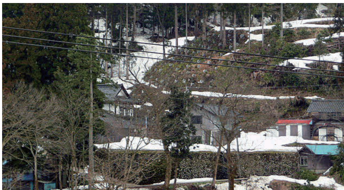
八尾町青根地区（地すべり対策事業）
