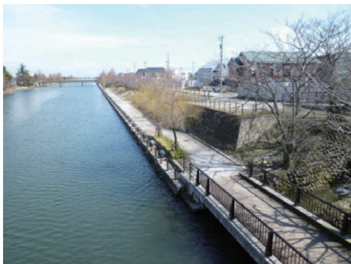
富岩運河（遊歩道の整備）
