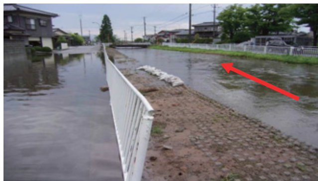
二級河川 下条川 平成20年7月 水橋狐塚地内
