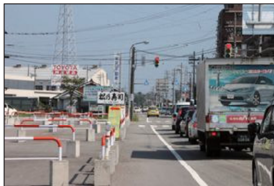
【東岩瀬線】 城川原地内
