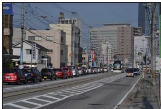
【綾田北代線】 永楽町地内
