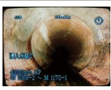
調査の結果、改築の必要ない下水道管
