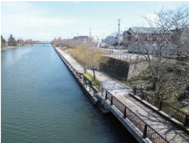
富岩運河（遊歩道の整備）
