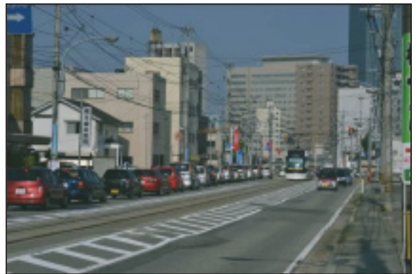
【綾田北代線】 永楽町地内
