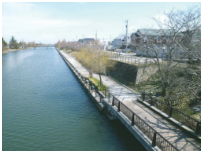
富岩運河（遊歩道の整備）
