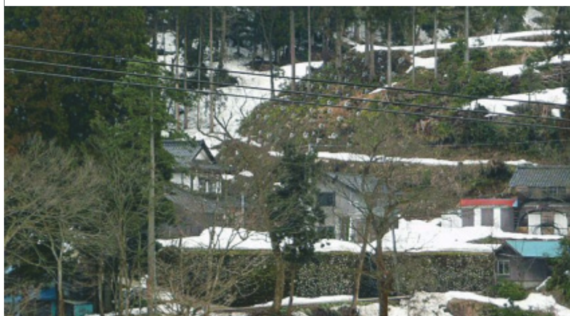
八尾町青根地区（地すべり対策事業）
