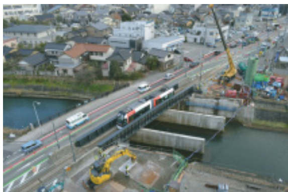
八田橋 1955年竣工 ・更新事業 H27～
