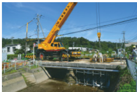
五福4号橋 1927年竣工 ・更新事業 H28 ・モニタリング技術実証試験 H28
