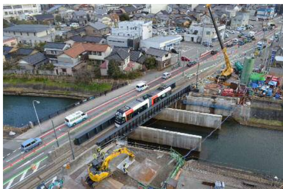
八田橋 1955年竣工 ・更新事業 H27～
