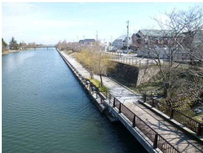
富岩運河（遊歩道の整備）
