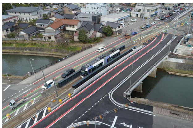
八田橋 1955年(昭和30年)竣工 ・大規模更新事業 平成27年～ [上流側平成30年3月竣工]
