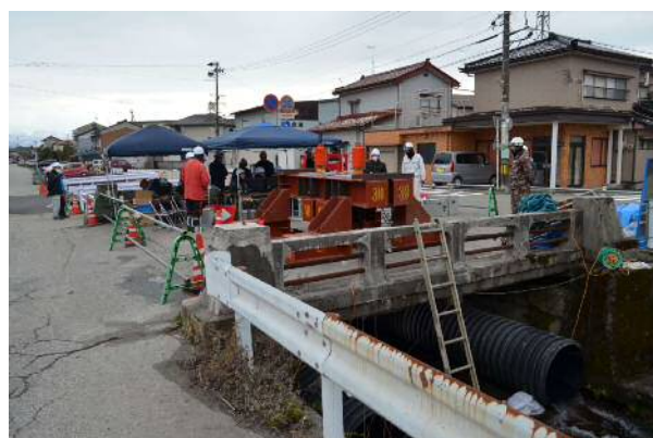
京都大学とモニタリング技術の共同研究 ・実橋での実証試験 平成31年1月
