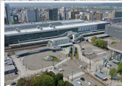
連続立体交差事業工事状況 (富山駅北口付近)
