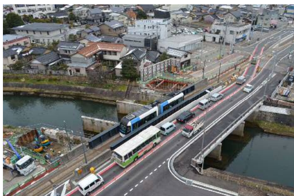
大規模更新事業（八田橋）平成27年～ 〔平成31年2月の現況〕
