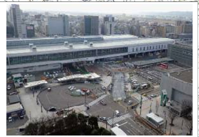
連続立体交差事業工事状況 (富山駅北口付近)
