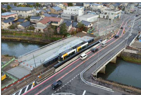
大規模更新事業（八田橋）平成27年～ 〔令和元年12月の状況〕
