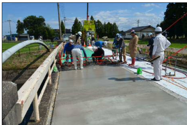
土木学会とのコンクリート舗装実証試験 〔令和元年10月〕
