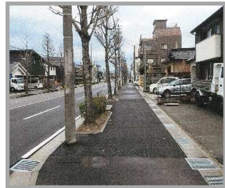
歩道のリフレッシュ整備
