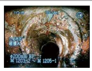
調査の結果、改築の必要がある下水道管
