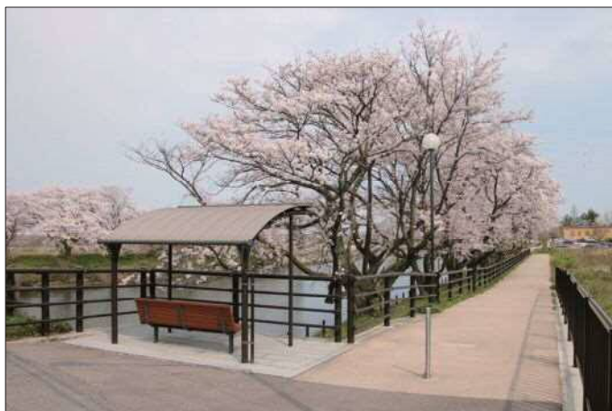
富岩運河（遊歩道の整備）
