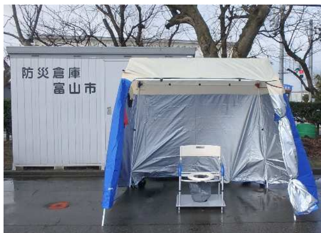
令和2年1月に完成したマンホールトイレ (倉垣小学校)
