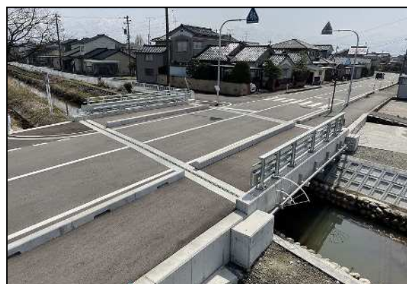
橋梁更新事業（水橋東部1号橋） 〔令和3年5月〕
