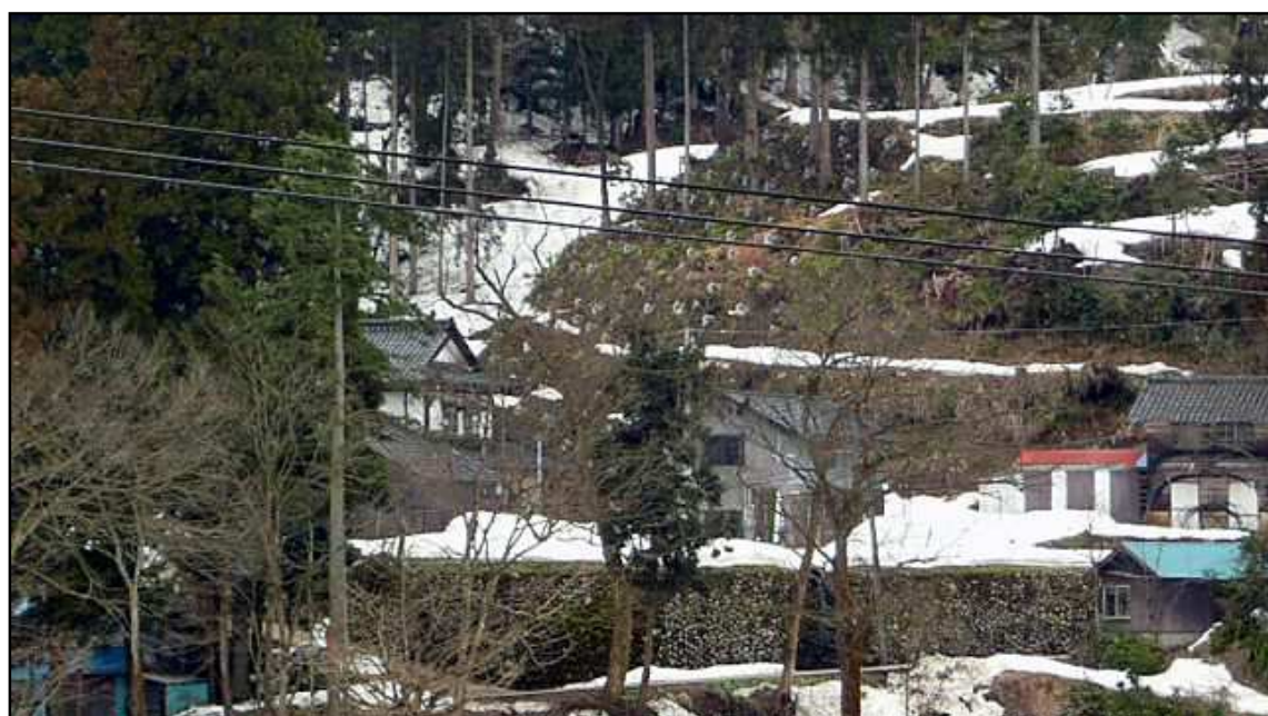
八尾町青根地区（地すべり対策事業）
