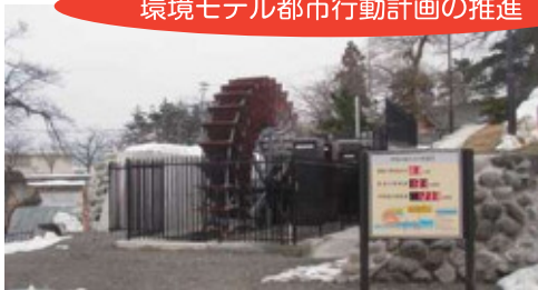
常西合口用水に整備した小水力発電所
