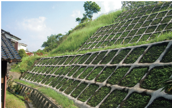
急傾斜地崩壊対策（茶屋町）
