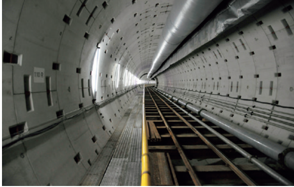
松川雨水貯留施設
