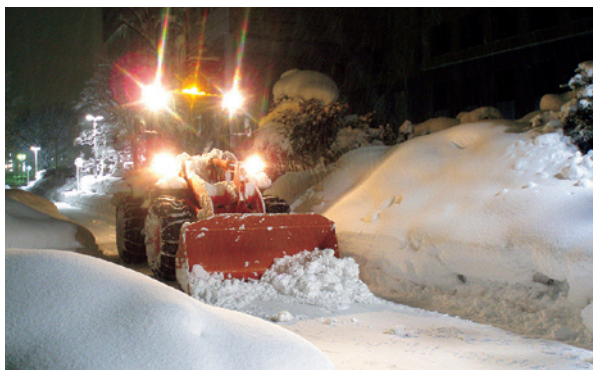
市内の除雪作業
