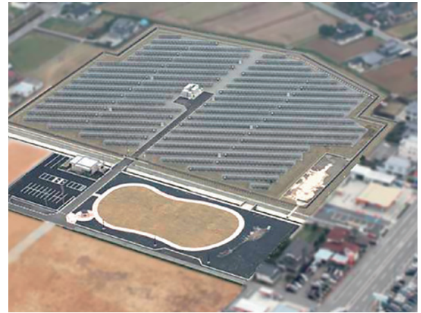
富山太陽光発電所
