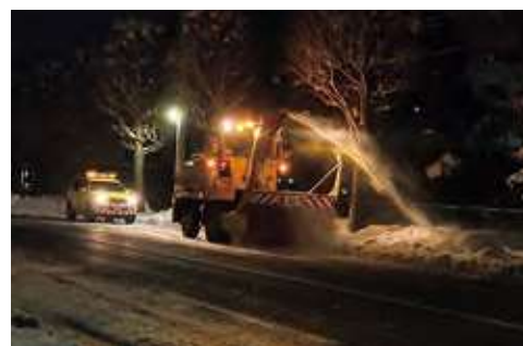
市内の除雪作業
