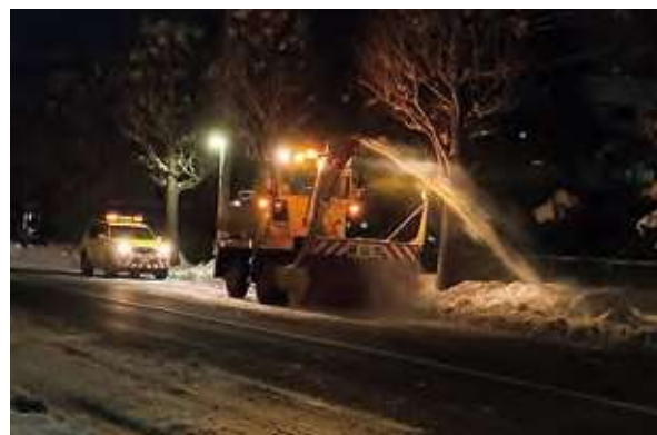
市内の除雪作業
