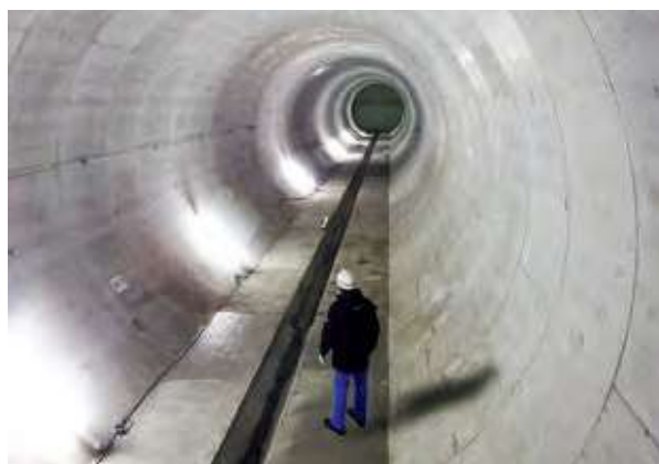
松川雨水貯留施設
