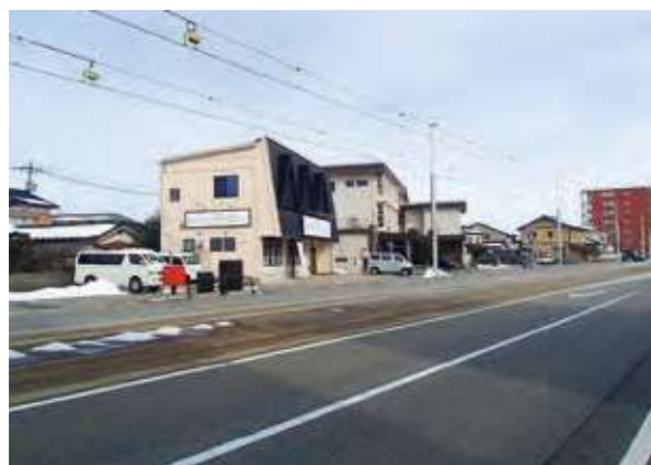
無電柱化事業（都市計画道路綾田北代線）
