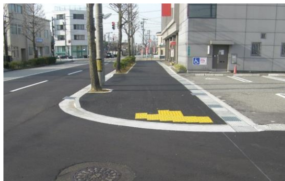
歩道の補修工事
