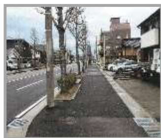
歩道のリフレッシュ整備
