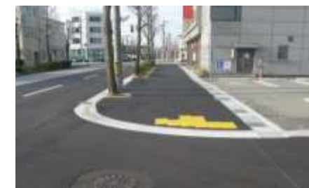
歩道の補修工事
