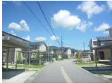
公共交通沿線の居住推進 (錦中町夢ヶ丘地区)
