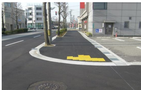
歩道の補修工事
