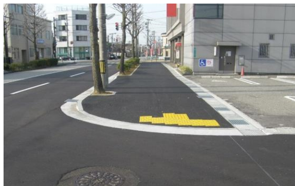
歩道の補修工事
