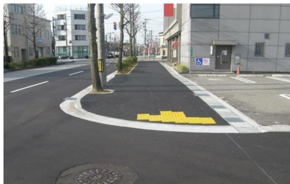
歩道の補修工事
