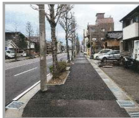
歩道のリフレッシュ整備
