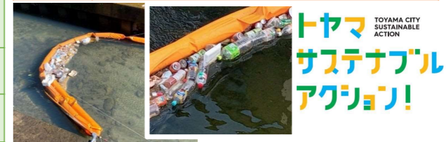
陸域からの流出抑制対策(オイルフェンス設置)
