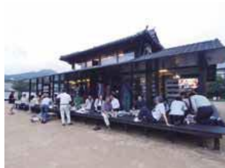
住民との交流が促進されるよう、ガラスの外壁や四周に縁側を設けた「えんがわオフィス」。
