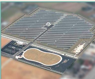
約3万m<sup>2</sup>の敷地に4,815枚の太陽光パネルを設置し、発電出力1,000kWで年間約100万kWh（約250世帯分の年間電気使用量）を発電します。
