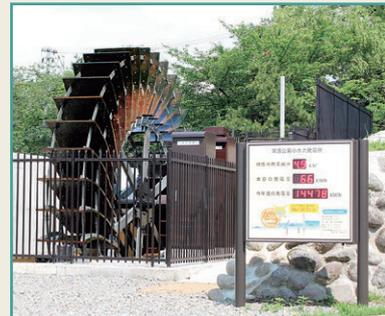
常願寺川を水源とする常西合口用水において、2か所の小水力発電を整備しました。2か所合わせた最大出力は、97.9kWで年間71.73万kWh、約200世帯分の年間電気使用量を発電します。
