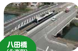
特殊な構造の橋 / ポータルラーメンレベーム合成桁橋
