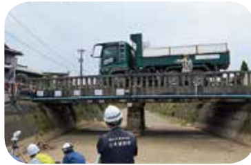
▲センサーの動作確認 (国立研究開発法人 土木研究所との実証実験)
