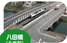
特殊な構造の橋 / ポータルメンブレン合流橋
