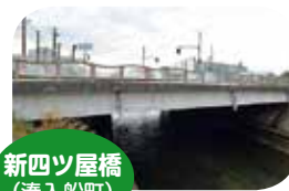
幅の広い橋 / 64m
