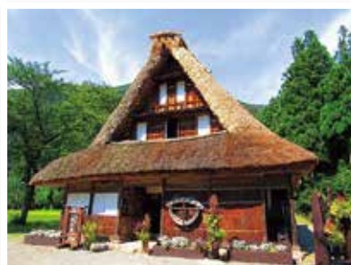
五箇山民俗館(南砺市)
