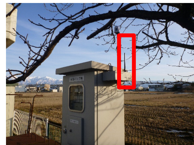
現場機器設置状況 (水橋中村町)
