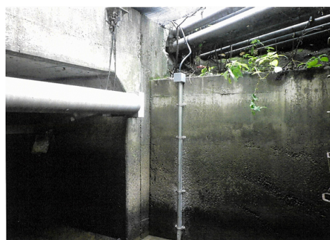
水位センサーの設置状況
