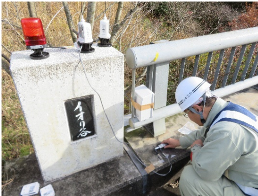
機材設置作業状況
