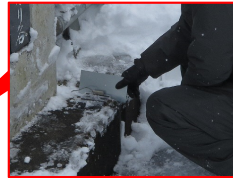
鉄板挿入による動作確認状況
