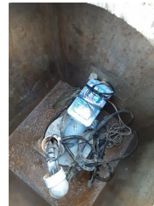
マンホール(中) 機器設置
