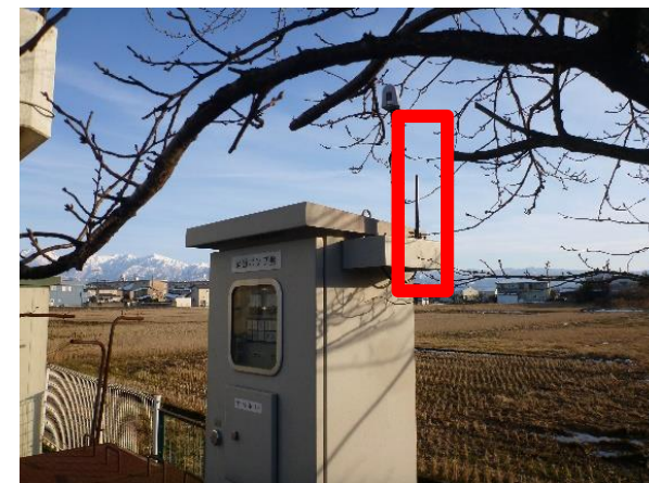
現場機器設置状況
