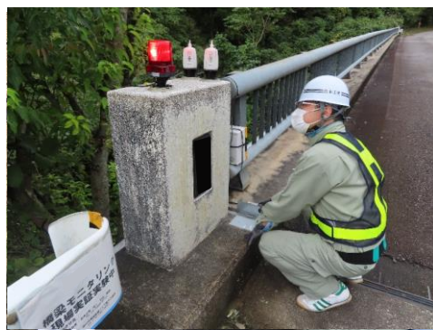
機材設置作業状況
