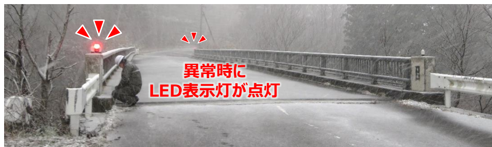
動作確認状況（全体写真）
