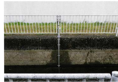
水位センサーの設置状況
