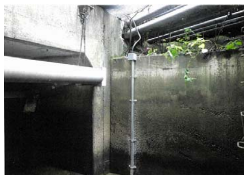
水位センサーの設置状況
