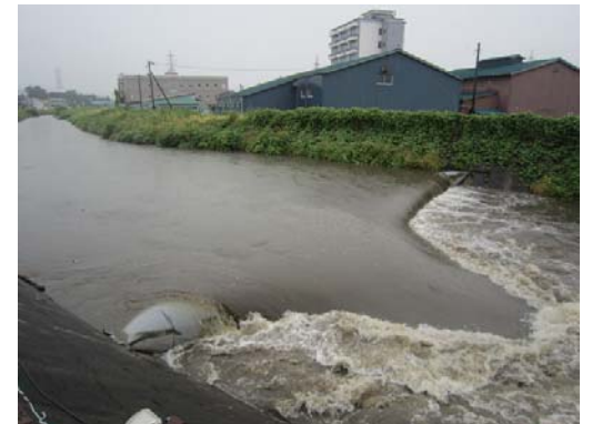
大雨時の土川頭首工
