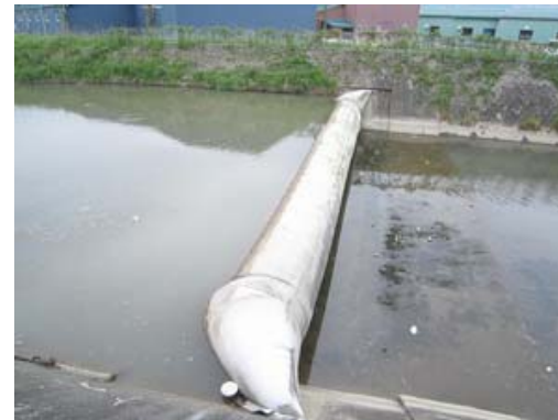
土川頭首工(富山市赤田地内)
