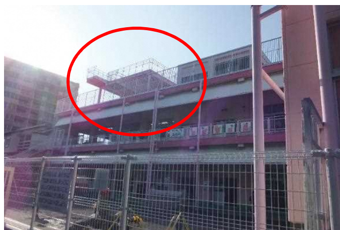
図 15 屋上への避難場所を増築した事例
