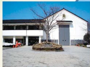
八尾曳山展示館
