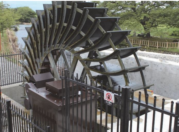
常西公園小水力発電所
