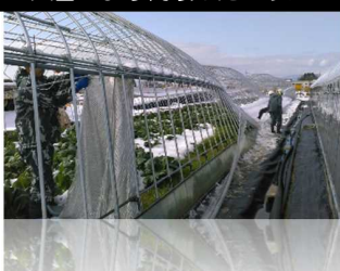
大雪により倒壊したハウス
