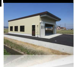
作業所の新設
