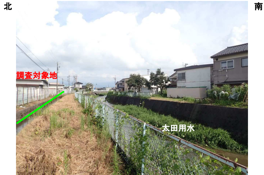
写真 4.2.4 調査対象地南側隣接地の利用状況
