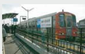
社会実験として平成20年3月に新設した「婦中鶴坂駅」
