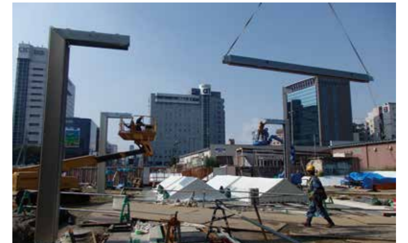
工事の様子(第1期事業)
