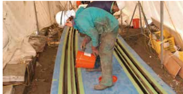
樹脂固定軌道
