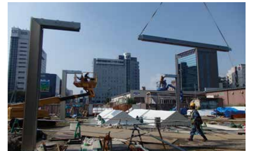
工事の様子(第1期事業)
