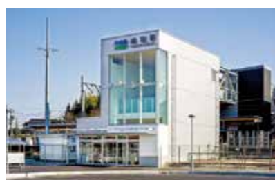
呉羽駅北口改札口（新設）
