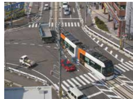
軌道区間(都市計画道路 綾田北代線)
