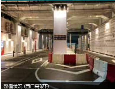
整備状況 (西口高架下)
