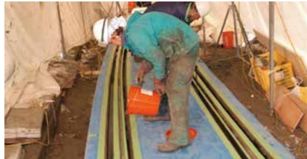
樹脂固定軌道
