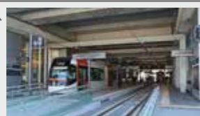
高架後の富山駅停留場
